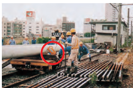
●電柱の荷締め・荷降し作業
