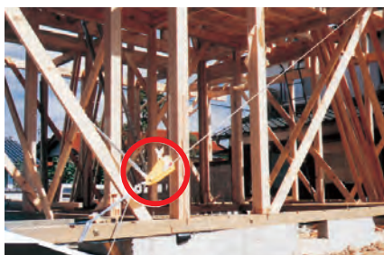
●木造・鉄骨建物の建起し作業
