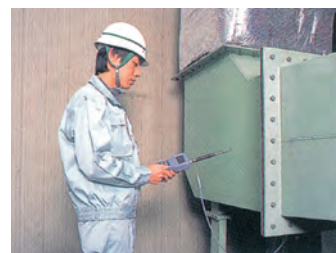
▲ダクト等の風力測定
