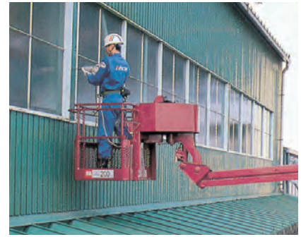
屋上や屋根に接近しての作業
