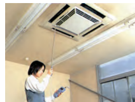
▲空調設備の点検
