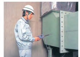
▲ダクト等の風力測定
