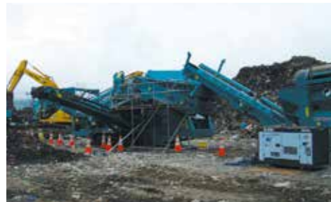
災害復旧現場でのスクリーン2台の連結
