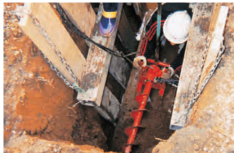
上下水道、ガス管布設工事での横掘推進工事
