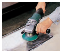
スーパーワイヤブラシによる塗装はがし作業
