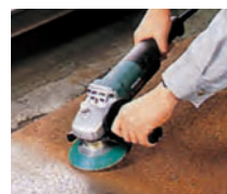
スーパーワイヤブラシによるサビ落とし作業
