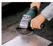
多羽根ディスクによる溶接ビード面仕上作業
