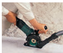
ダイヤモンドホイールによるコンクリートへの溝入れ作業
