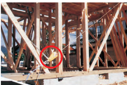
●木造・鉄骨建物の建起し作業
