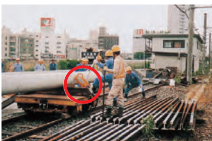
●電柱の荷締め・荷降し作業
