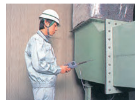
▲ダクト等の風力測定
