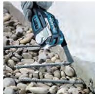
鉄筋の面一切断
