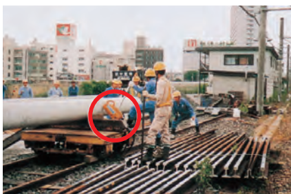
●電柱の荷締め・荷降し作業
