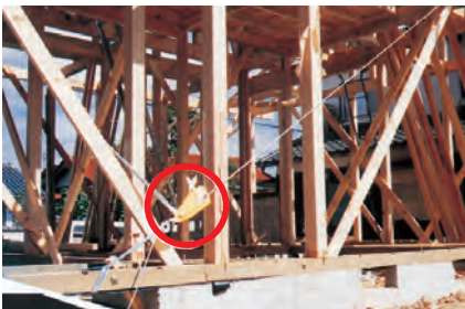
●木造・鉄骨建物の建起し作業
